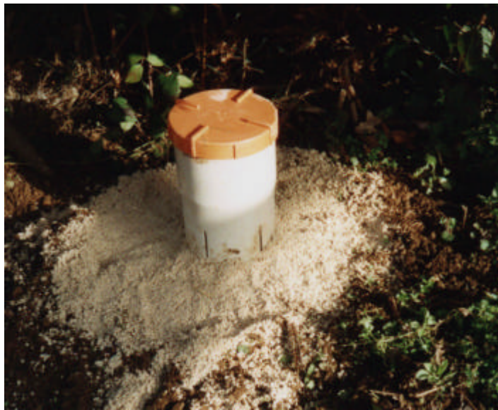
FOTO 5 - Il pozzetto condizionato a sistemazione ultimata prima della sigillatura
