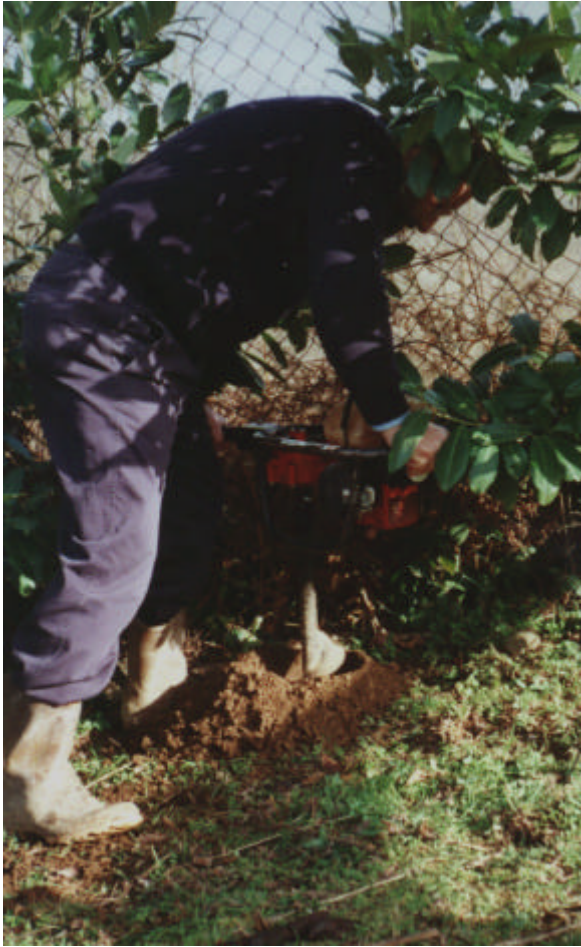
FOTO 1 - La realizzazione del perforo Ø 150 mm con trivella motorizzata a mano Komatsu
