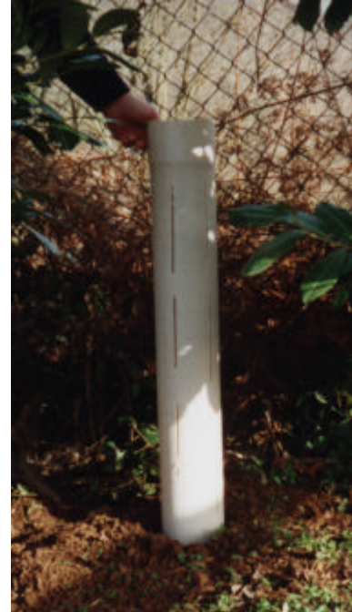
FOTO 2 - Installazione tubo in PVC Ø 125 mm con le finestre realizzate nel corpo del tubo
